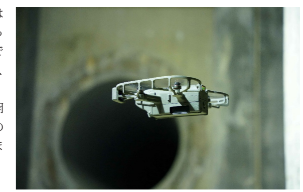
管路などの狭小・暗所でのドローン点検の様子
