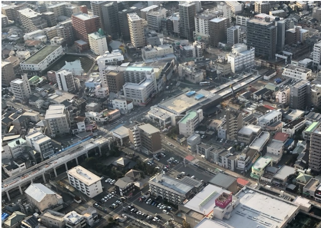
西鉄春日原駅周辺で進む連続立体交差事業
